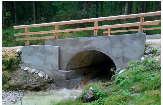
Bei guter Bausubstanz genügt eine Betonsanierung, wie hier am Klausgraben
