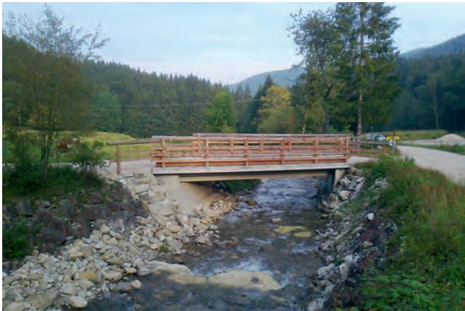
Kohlhäusbrücke mit Fertigteilträgern und Ortbetoneingängung
