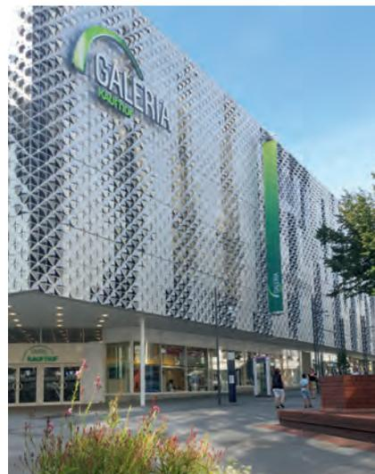
Für die Galeria Kaufhof in Pforzheim wurde die Fassade aus Keramikelementen von 1961 durch 2.000 lasergeschnittene Paneele aus Aluminium ersetzt.
