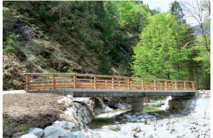
Steinbach-Grenzgrabenbrücke, Stahlträger und 2-Feld Fertigteilplatte
